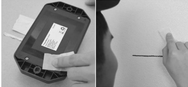
2. Busque la ampolla de imprimación universal 3M VHB suministrada con el kit adhesivo. Aplique la imprimación en la parte posterior del dispositivo al que se aplicará la cinta.
