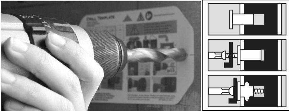
3. Retire la plantilla. En este momento, dispondrá de dos orificios en la puerta. Si hubiera alguna rebaba alrededor de los orificios, retírela. Elimine también cualquier resto o polvo que pueda quedar tras la perforación o la eliminación de rebabas.
