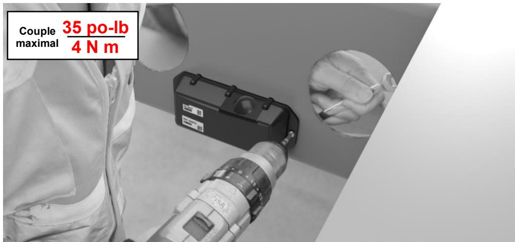
**Conseil :** si vous choisissez d'utiliser une vis autotaraudeuse sur une surface d'installation dont la construction laisse l'extrémité pointue de la vis exposée, vous pourrez la retirer lorsque le module sera monté sur le châssis. Cela peut éviter les risques de blessures ou de dommages dus aux extrémités pointues de la vis.
