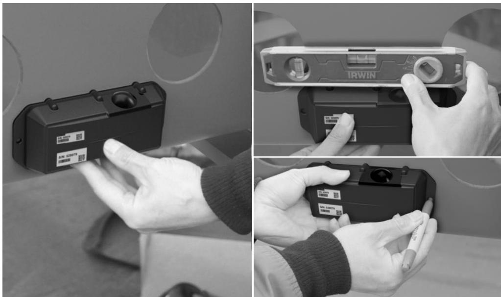
3. Utilisez un foret pour percer un trou à chaque repère du guide. Les deux trous percés serviront à fixer le module.
