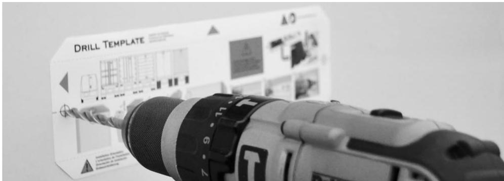
3. Después de taladrar los orificios y retirar la plantilla, instale las tuercas ciegas en los orificios.
