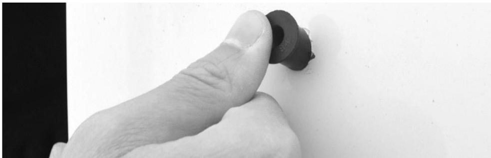
4. Placez le module sur la porte en alignant les trous du module avec ceux des écrous à sertir. Insérez l'attache choisie dans les trous du module et les écrous à sertir. Utilisez les outils correspondants pour fixer le module à l'actif.
