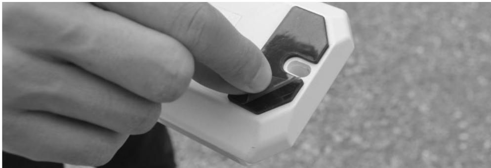
6. Placez le module sur la porte, en alignant les trous du module avec ceux que vous avez percés dans la porte. Pour engager l'adhésif, appuyez fermement le module contre la surface d'installation pendant 30 à 45 secondes.
