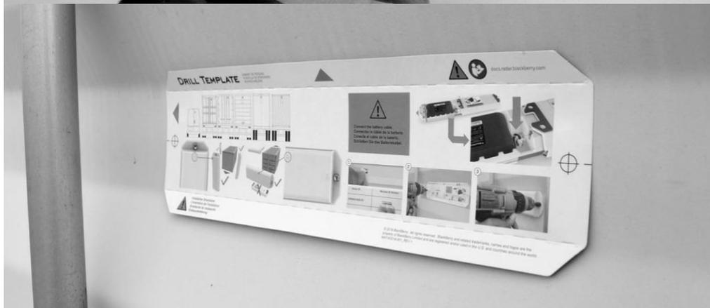
3. Con una broca, taladre un orificio a través de cada retículo de la plantilla. Así creará los dos orificios que utilizará para montar el módulo.
