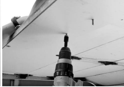
**Colocación en una parte baja de la puerta: tuercas, pernos y arandelas únicamente**
