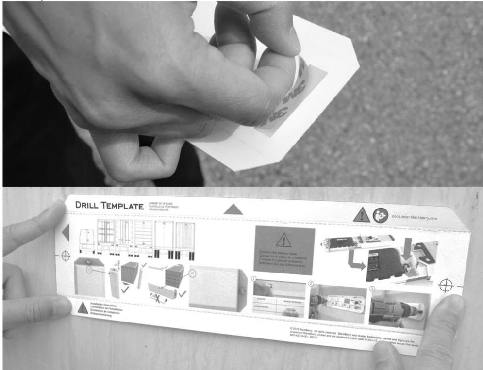
5. Con una broca, taladre un orificio a través de cada retículo de la plantilla. Así creará los dos orificios que utilizará para montar el módulo.
