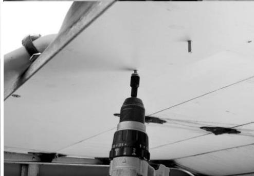
6. Retire la plantilla. En este momento, dispondrá de dos orificios en la puerta. Si hubiera alguna rebaba alrededor de los orificios, retírela. Elimine también cualquier resto o polvo que pueda quedar tras la perforación o la eliminación de rebabas.
