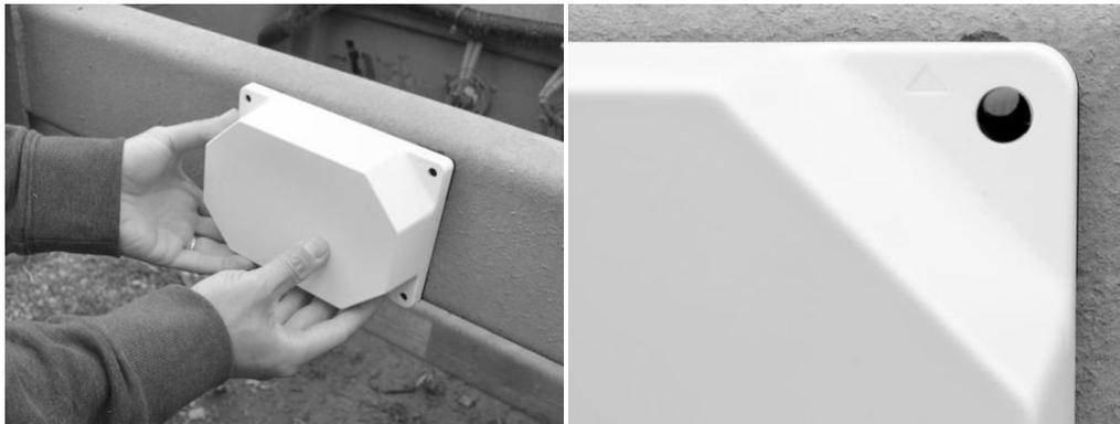
6. Insérez les attaches choisies dans les trous et utilisez les outils correspondants pour fixer le module à l'actif.
