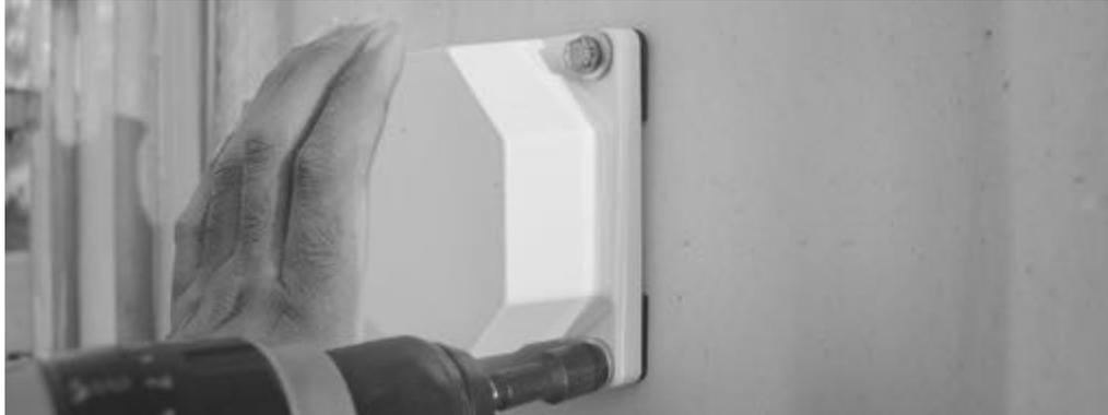
No apriete demasiado el tornillo de fijación. Un apriete excesivo pueden comprimir demasiado la junta de montaje y esta puede quedar dañada. No apriete el tornillo de fijación más de 4 N-m (35 in-lb).
