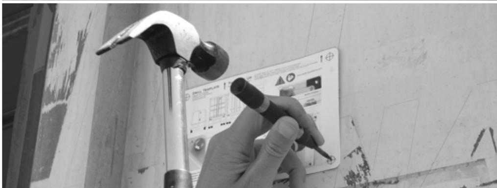
**Sugerencia:** Si el activo está aislado (por ejemplo, frigorífico o calefactado) y desea evitar pérdidas de temperatura debidas a la perforación completa de la puerta, le recomendamos que limite la profundidad de perforación. Para realizar la instalación mediante este método, necesitará tuercas ciegas.
