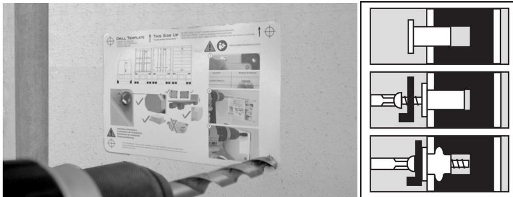
5. Retire la plantilla. En este momento, dispondrá de cuatro orificios en la puerta. Si hubiera alguna rebaba alrededor de los orificios, retírela. Elimine también cualquier resto o polvo que pueda quedar tras la perforación o la eliminación de rebabas.
