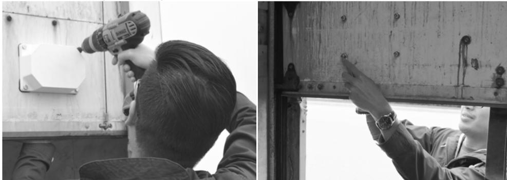
**IMPORTANT** : si votre emplacement est situé en bas de la porte, il est important de relever complètement la porte sur toute sa course, puis de l'abaisser complètement pour initialiser le capteur d'orientation de la porte. Cette opération permet au capteur de reconnaître la différence entre un évènement d'ouverture et de fermeture de porte.
