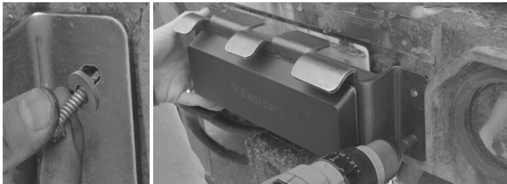
**Conseil :** pour simplifier l'installation, vous pouvez installer les attaches selon la séquence indiquée sur le guide. Cette séquence d'installation permet de mieux soutenir le poids de l'assemblage du support pendant que vous installez les autres attaches.
