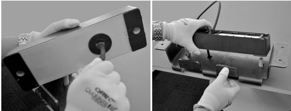
10. Placez les vis dans les emplacements pour vis. Utilisez les vis pour fixer les modules au support.
