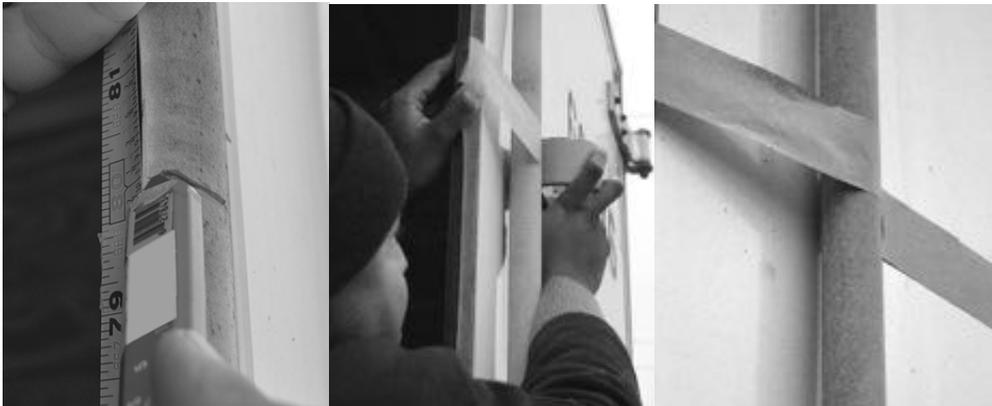
**Sugerencia:** Para tráileres y contenedores con puertas enrollables, una vez que haya determinado la altura para la instalación, realice dos mediciones de posición, marcando cada punto en la pared exterior y, a continuación, trace una línea recta entre estos dos puntos. Esto garantizará que su línea sea paralela a la parte inferior de la puerta.
