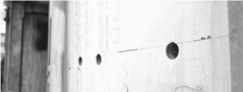
2. Hágase con un conjunto de tapones (de nailon, goma o metal) con el diámetro adecuado para tapar los orificios. Estos tapones se pueden adquirir en tiendas de ferretería o suministros para automoción. Introduzca los tapones en los orificios. Si lo desea, puede aplicar sellador para exteriores 100 % de silicona en la parte posterior de los tapones para aumentar la protección y sellar los huecos frente a la entrada de agua.
