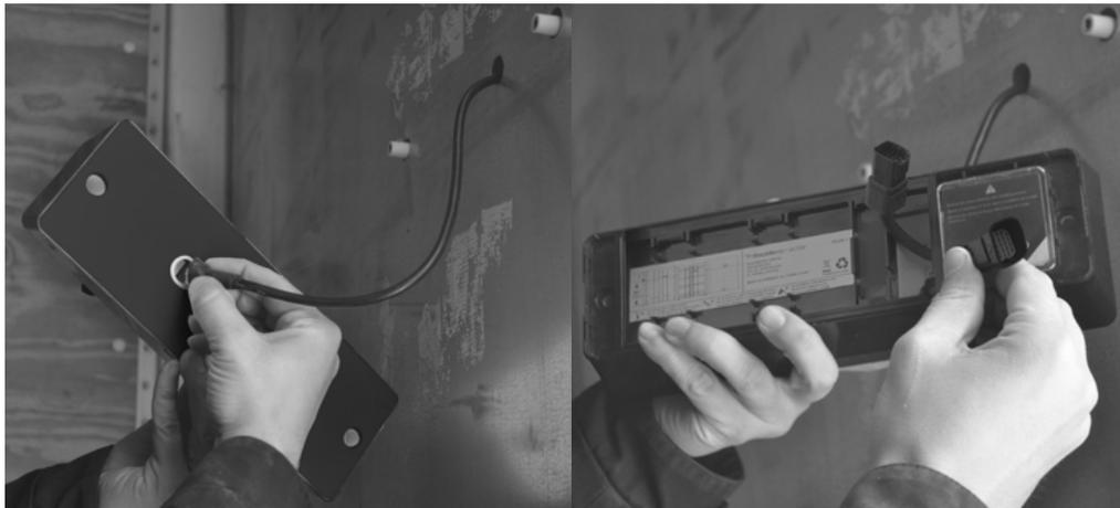
15. Coloque el módulo interno en los tornillos de refuerzo. Utilice los tornillos para fijar el módulo externo al interno. No apriete en exceso las piezas de fijación. No supere los 48 in-lb o 5 Nm.
