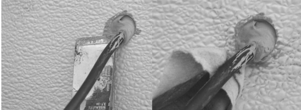
14. Desde dentro del contenedor, busque el cable y pase el conector del cable a través del orificio de la parte trasera del módulo interno. Pase el módulo interno a través del cable, hacia la puerta.
