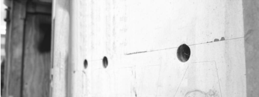
2. Llene los orificios con un sellador resistente al agua. Si lo desea, puede utilizar sellador para exteriores 100 % de silicona o sellador de poliuretano.
