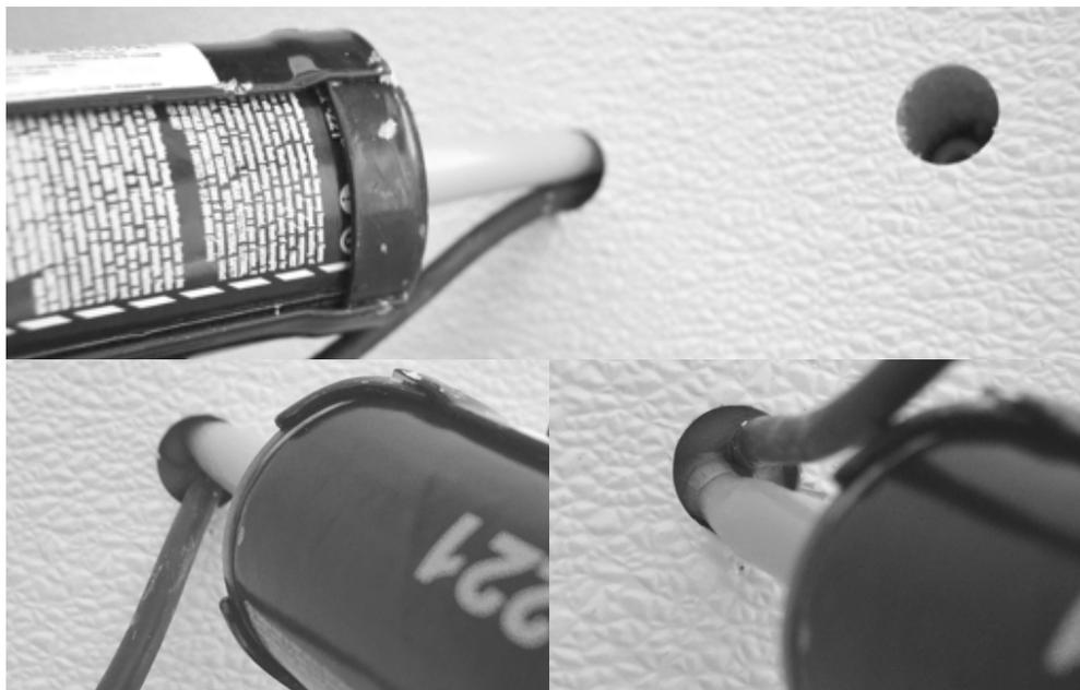
13. Si el sellador se expande hacia la superficie interna de la puerta, asegúrese de retirar el exceso de aislamiento de la superficie de la puerta. Para realizar correctamente la instalación, es importante que el dispositivo quede a ras de la superficie de instalación. Puede retirarse el exceso de sellador con una espátula y un paño impregnado en alcohol.
