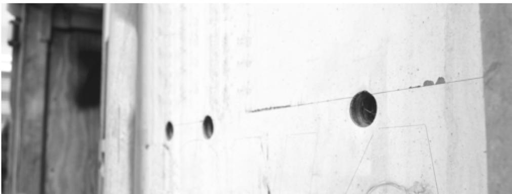
2. Bouchez-les avec un enduit résistant aux intempéries. Si vous le souhaitez, vous pouvez utiliser un mastic 100 % silicone adapté à l'extérieur ou un enduit en polyuréthane.
