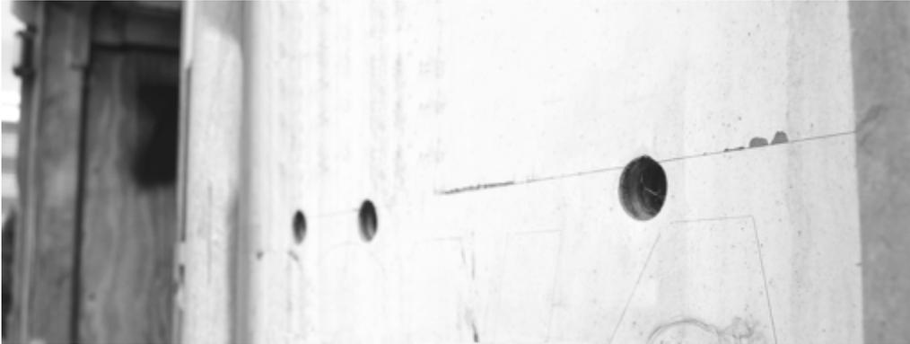
2. Procurez-vous un ensemble de bouchons (en nylon, en caoutchouc ou en métal) d'un diamètre adapté pour boucher les trous. Ces bouchons sont disponibles dans des magasins de bricolage ou d'approvisionnement automobile. Insérez les bouchons dans les trous. Si vous le souhaitez, vous pouvez ajouter du mastic 100 % silicone adapté à l'extérieur, à l'arrière du bouchon, pour une protection supplémentaire et pour éviter les infiltrations d'eau.
