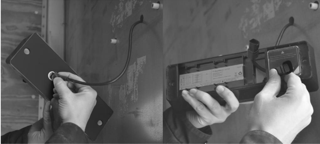
15. Installez le module interne sur les bossages à vis. Fixez le module interne au module externe à l'aide des vis. Ne serrez pas trop les fixations. Ne dépassez pas 48 pouces-livres, ou 5 Newton-mètres.
