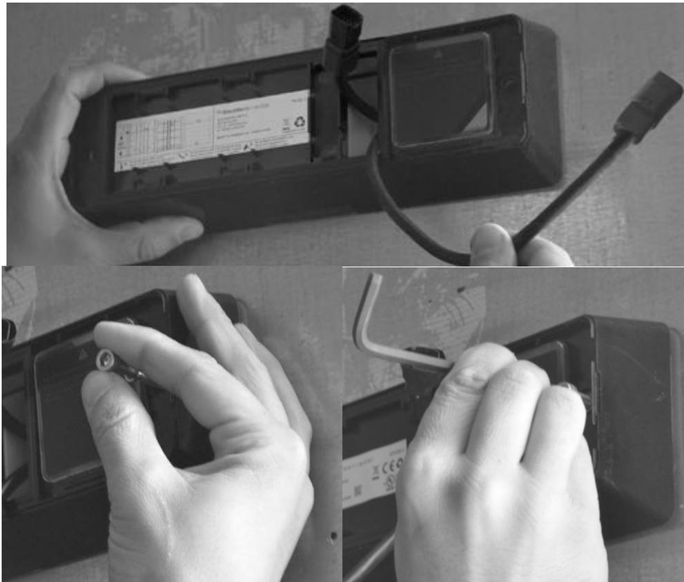
**Conseil :** pour visser plus rapidement, vous pouvez utiliser un embout hexagonal de 5 mm sur une perceuse sans fil. Si vous installez les vis avec la perceuse, veillez à ne pas trop les serrer (ne dépassez pas 48 pouces-livres, ou 5 Newton-mètres).
