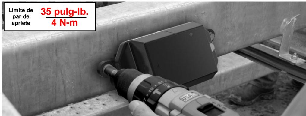
**Sugerencia:** Si elige utilizar un tornillo autoperforante en una superficie de instalación cuya construcción deja expuesto la punta afilada del tornillo, quite el extremo puntiagudo del tornillo después de montar el módulo en el chasis. Esto puede evitar posibles lesiones o daños provocados por los extremos expuestos de los tornillos.
