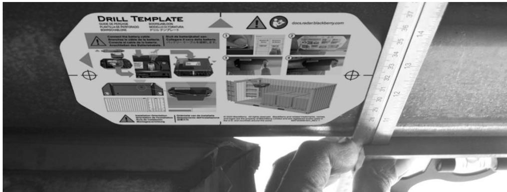
4. Con una broca, perfora un orificio a través de cada una de las cruces de la plantilla. De esta forma, creará dos orificios que utilizará para montar el módulo.
