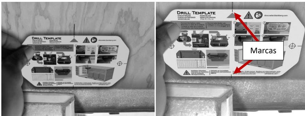
**Técnica 2:** De manera visual, coloque la plantilla en la ubicación de instalación deseada. Con una escuadra o un nivel, compruebe que la plantilla esté recta.
