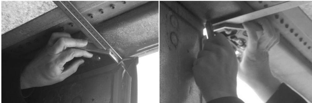
4. Coloque la plantilla de instalación en el techo. Asegúrese de que la línea central de la plantilla esté alineada con la línea central del techo. Trace el contorno de la plantilla en el techo. Una vez que se haya completado el trazado, quite la plantilla.
