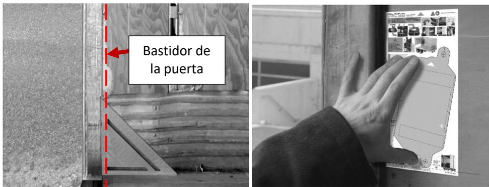
**Técnica 2:** De manera visual, alinee la línea punteada cerca de la parte inferior de la plantilla con la marca que creó en la pared. Con una escuadra o nivel, confirme que la plantilla esté nivelada y que el borde inferior de la plantilla esté paralelo al piso.
