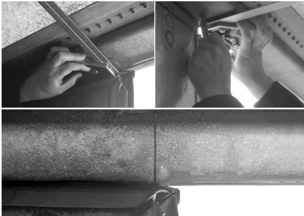
3. Retire los recubrimientos de la parte posterior de la plantilla y coloque la plantilla en el lugar de instalación deseado. El adhesivo en la parte posterior de la plantilla garantiza que permanezca en la superficie del bastidor de la puerta para perforar los orificios con precisión.
