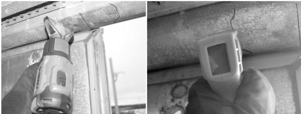
8. Ubique la ampolla de imprimador universal 3M VHB que se incluyó en el kit adhesivo. Aplique el imprimador a la superficie de instalación.
