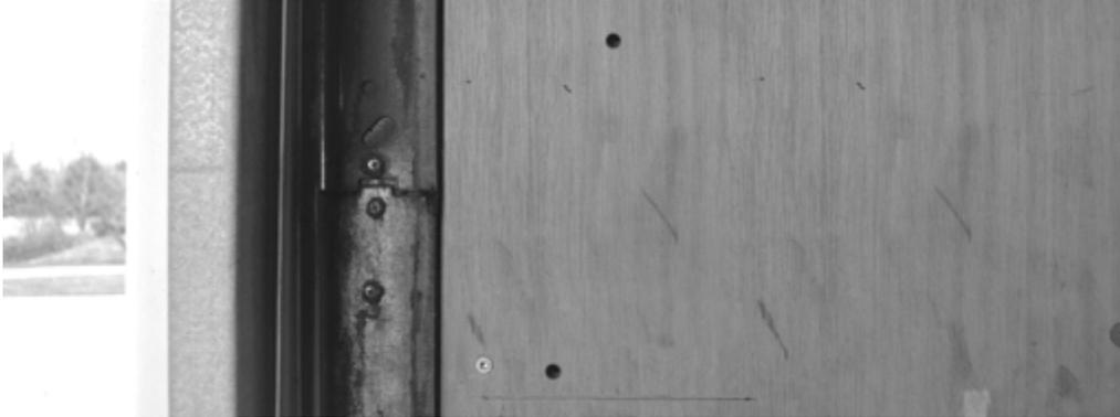
2. Llene los orificios con un sellador resistente al agua. Si lo desea, puede utilizar sellador para exteriores 100 % de silicona o sellador de poliuretano.
