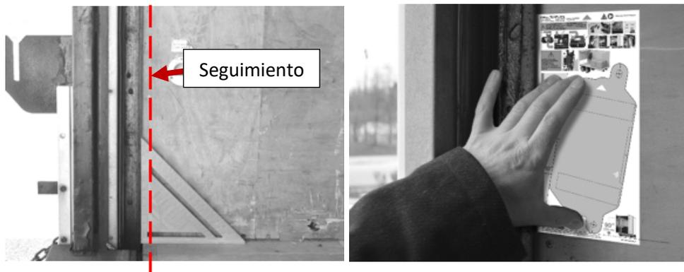
**Técnica 2:** De manera visual, alinee la línea punteada cerca de la parte inferior de la plantilla con la marca que creó en la pared. Con una escuadra o nivel, confirme que la plantilla esté nivelada y que el borde inferior de la plantilla esté paralelo al piso.
